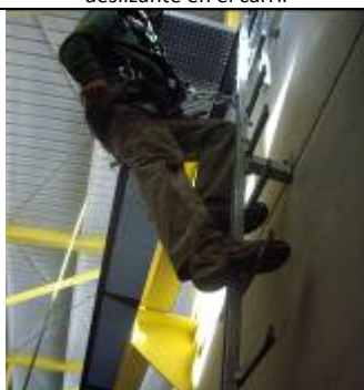
Figura 7.- Ascenso con dispositivo anticaídas deslizante Tipo AL-R
