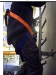
Figura 19.- Descenso con dispositivo anticaídas deslizante Tipo AL-R
