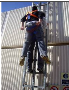
Figura 25.- Paso 3.- Pequeño impulso hacia arriba para desbloquear el dispositivo anticaídas deslizante
