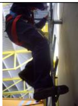
Figura 8.- Ascenso con dispositivo anticaídas deslizante Tipo AL-D (dotado de disipador de energía)
