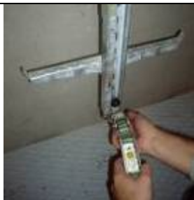
Figura 5. Instalación del dispositivo anticaídas deslizante en el carril
