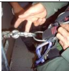
Figura 17.- Anclarse al dispositivo anticaídas deslizante
