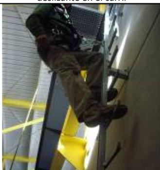
Figura 7.- Ascenso con dispositivo anticaídas deslizante Tipo AL-R
