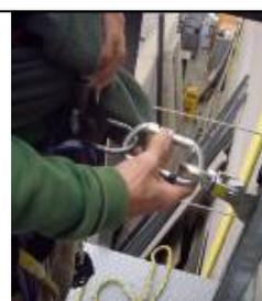
Figura 21.- Desconexión del dispositivo anticaídas deslizante
