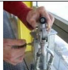
Figuras 10, 11 y 12- Giro de la parte móvil y extracción del carro del carril
