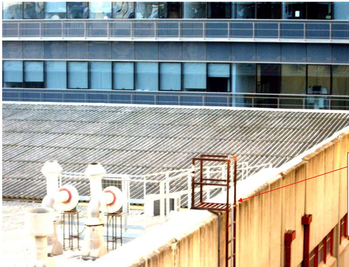
Instalación de dispositivo anticaídas deslizante sobre línea de anclaje rígida (carril a escala).
