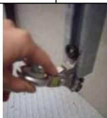
Figura 22.- Extracción del dispositivo anticaídas deslizante del carril
