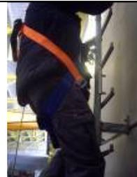
Figura 19.- Descenso con dispositivo anticaídas deslizante Tipo AL-R
