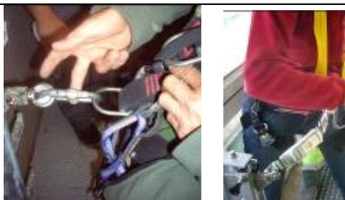
Figura 17.- Anclarse al dispositivo anticaídas deslizante
