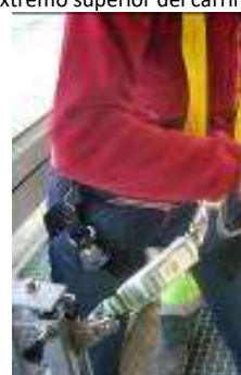
Figura 18.- Anclarse al dispositivo anticaídas deslizante
