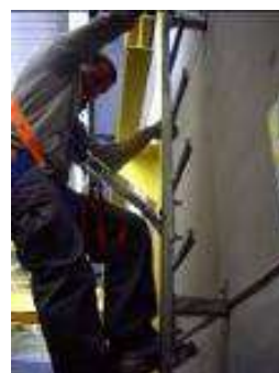
Figura 20.- Descenso con dispositivo anticaídas deslizante
