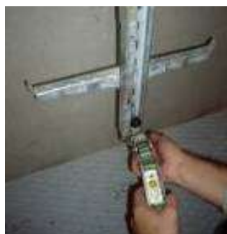
Figura 7. Instalación del dispositivo anticaídas deslizante en el carril
