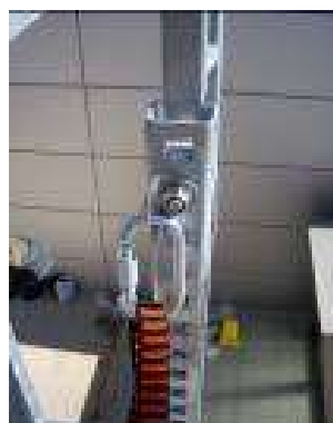
Figura 10.- Conexión del extremo libre del elemento de amarre a placa y/o punto de anclaje
