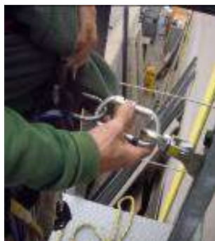
Figura 21.- Desconexión del carril del dispositivo anticaídas deslizante
