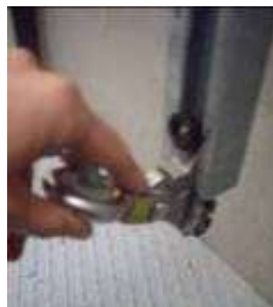
Figura 22.- Extracción del carril del dispositivo anticaídas deslizante
