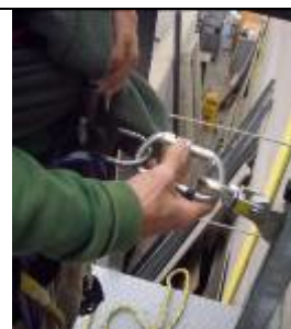
Figura 21 – Desconexión del dispositivo anticaídas deslizante
