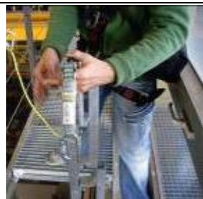
Figura 15.- Colocar el dispositivo anticaídas deslizante en el extremo superior del carril
