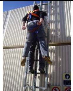
Figura 25.- Paso 3.- Pequeño impulso hacia arriba para desbloquear el dispositivo anticaídas deslizante
