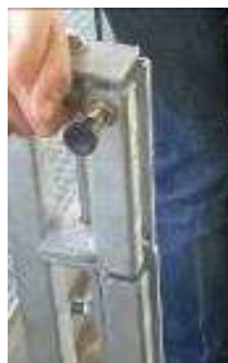
Figura 14.- Alineaci3n del extremo superior m3vil con el resto del carril
