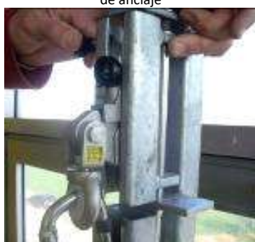
Figura 17.- Alineación del carril
