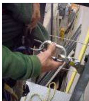
Figura 21.- Desconexión del carril del dispositivo anticaídas deslizante
