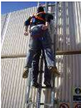
Figura 25.- Paso 3: Peque1o impulso hacia arriba para desbloquear el dispositivo antica3das deslizante
