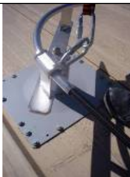
Colocación del carro en puntos de unión de líneas de vida
