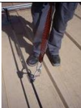
Anclaje del elemento de amarre al carro
