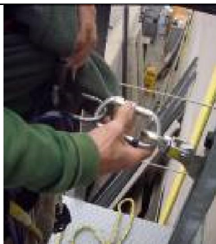
Figura 20.- Desconexión del carril del dispositivo anticaídas deslizante
