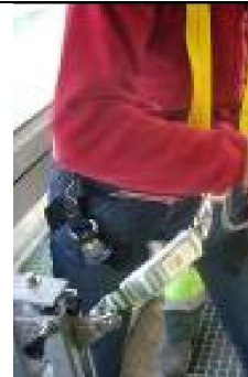
Figura 17.- Anclarse al dispositivo anticaídas deslizante
