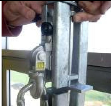
Figura 16.- Alineación del carril
