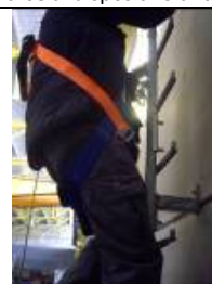
Figura 19.- Descenso con dispositivo anticaídas deslizante Tipo AL-R
