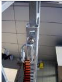
Figura 14.- Conexión del elemento de amarre a la placa y/o punto de anclaje
