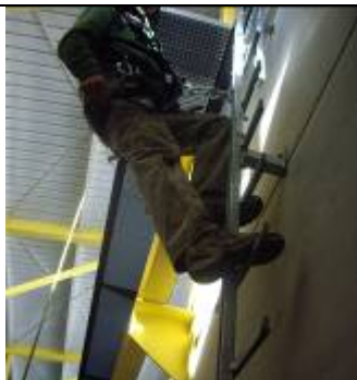
Figura 7.- Ascenso con dispositivo anticaídas deslizante Tipo AL-R
