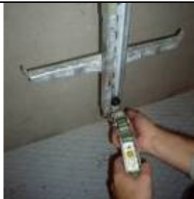
Figura 5. Instalación del dispositivo anticaídas deslizante en el carril
