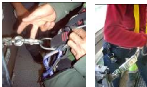
Figura 17.- Anclarse al dispositivo anticaídas deslizante
