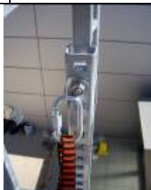
Figuras 9.- Conexión del extremo libre del elemento de amarre a placa y/o punto de anclaje
