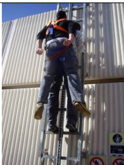
Figura 28.- Paso 3.- Pequeño impulso hacia arriba para desbloquear el dispositivo anticaídas deslizante del accidentado
