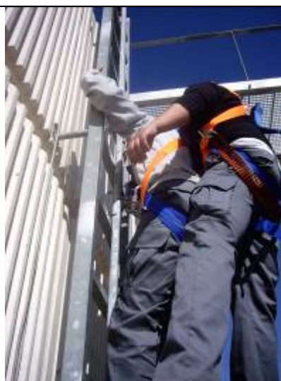
Figura 29.- Paso 4.- Iniciar el descenso
