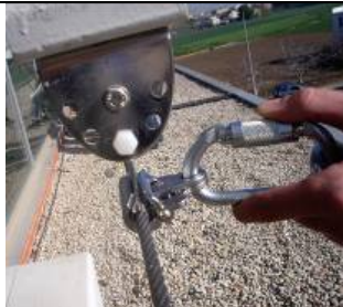
Colocación del carro en puntos de unión de los vanos en la misma línea de vida
