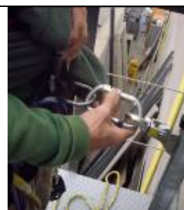
Figura 21.- Desconexión del dispositivo anticaídas deslizante
