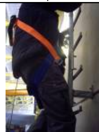
Figura 19.- Descenso con dispositivo anticaídas deslizante Tipo AL-R
