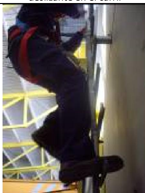
Figura 8.- Ascenso con dispositivo anticaídas deslizante Tipo AL-D (dotado de absorbedor de energía)
