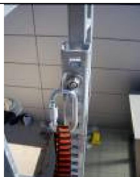
Figuras 9.- Conexi3n del extremo libre del elemento de amarre a placa y/o punto de anclaje
