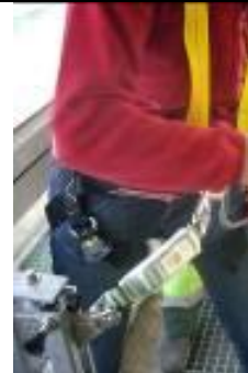
Figura 17.- Anclarse al dispositivo anticaídas deslizante
