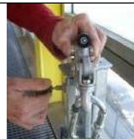
Figuras 9.- Conexi3n del extremo libre del elemento de amarre a placa y/o punto de anclaje
