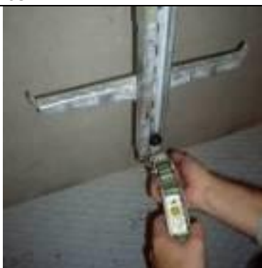
Figura 5. Instalaci3n del dispositivo anticaídas deslizante en el carril
