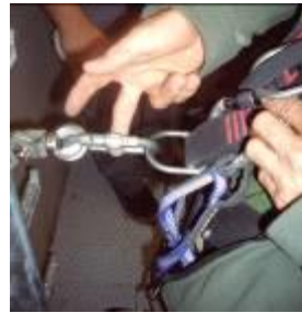
Figura 6.- Anclaje al dispositivo anticaídas deslizante
