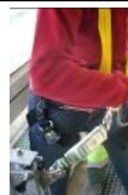
Figura 17.- Anclarse al dispositivo anticaídas deslizante
