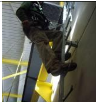
Figura 7.- Ascenso con dispositivo anticaídas deslizante Tipo AL-R
