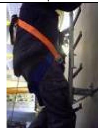
Figura 19.- Descenso con dispositivo anticaídas deslizante Tipo AL-R
