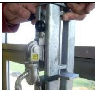
Figura 16.- Alineación del carril
