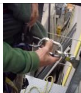
Figura 21 – Desconexión del dispositivo anticaídas deslizante
