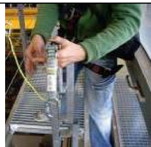
Figura 15.- Colocar el dispositivo anticaídas deslizante en el extremo superior del carril
