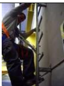
Figura 20.- Descenso con dispositivo anticaídas deslizante Tipo AL-D (dotado de disipador de energía)
