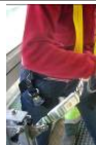
Figura 17.- Anclarse al dispositivo anticaídas deslizante
