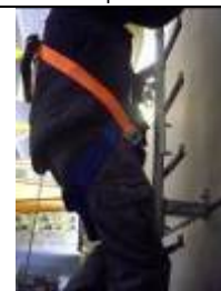
Figura 19.- Descenso con dispositivo anticaídas deslizante Tipo AL-R
