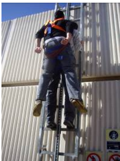
Figura 25.- Paso 3.- Pequeño impulso hacia arriba para desbloquear el dispositivo anticaídas deslizante del accidentado
