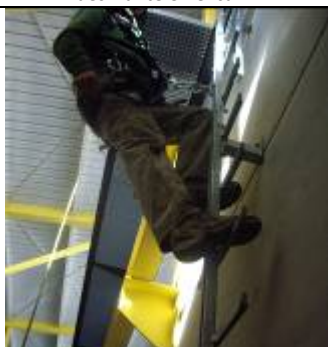
Figura 7.- Ascenso con dispositivo anticaídas deslizante Tipo AL-R
