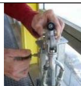
Figuras 9.- Conexión del extremo libre del elemento de amarre a placa y/o punto de anclaje
