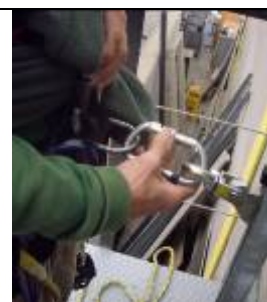
Figura 21.- Desconexión del dispositivo anticaídas deslizante
