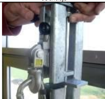
Figura 16.- Alineación del carril
