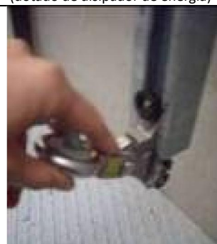
Figuras 21 – Extracción del carril del dispositivo anticaídas deslizante
