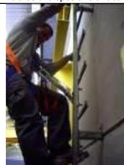
Figura 19.- Descenso con dispositivo anticaídas deslizante Tipo AL-D (dotado de disipador de energía)
