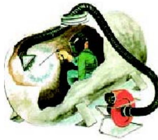
Ventilación por extracción localizada
